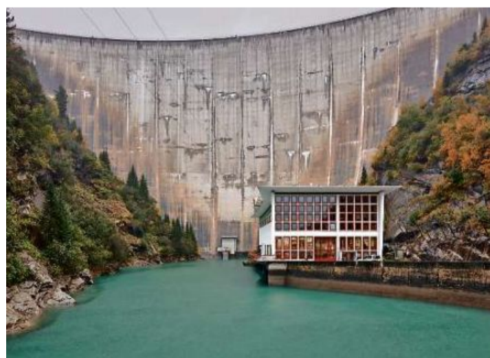
Im Schatten der monumentalen Zervreila-Staumauer behauptet sich die fast schwerelos erscheinende Kraftwerkzentrale. Bild: Ralph Feiner
