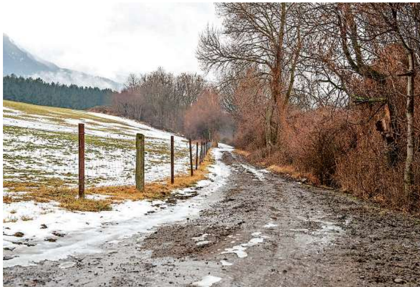
Kompromiss gefunden: Beim Belag im Abschnitt Witenen wird Rücksicht auf das Bundesinventar historischer Verkehrswege genommen.
