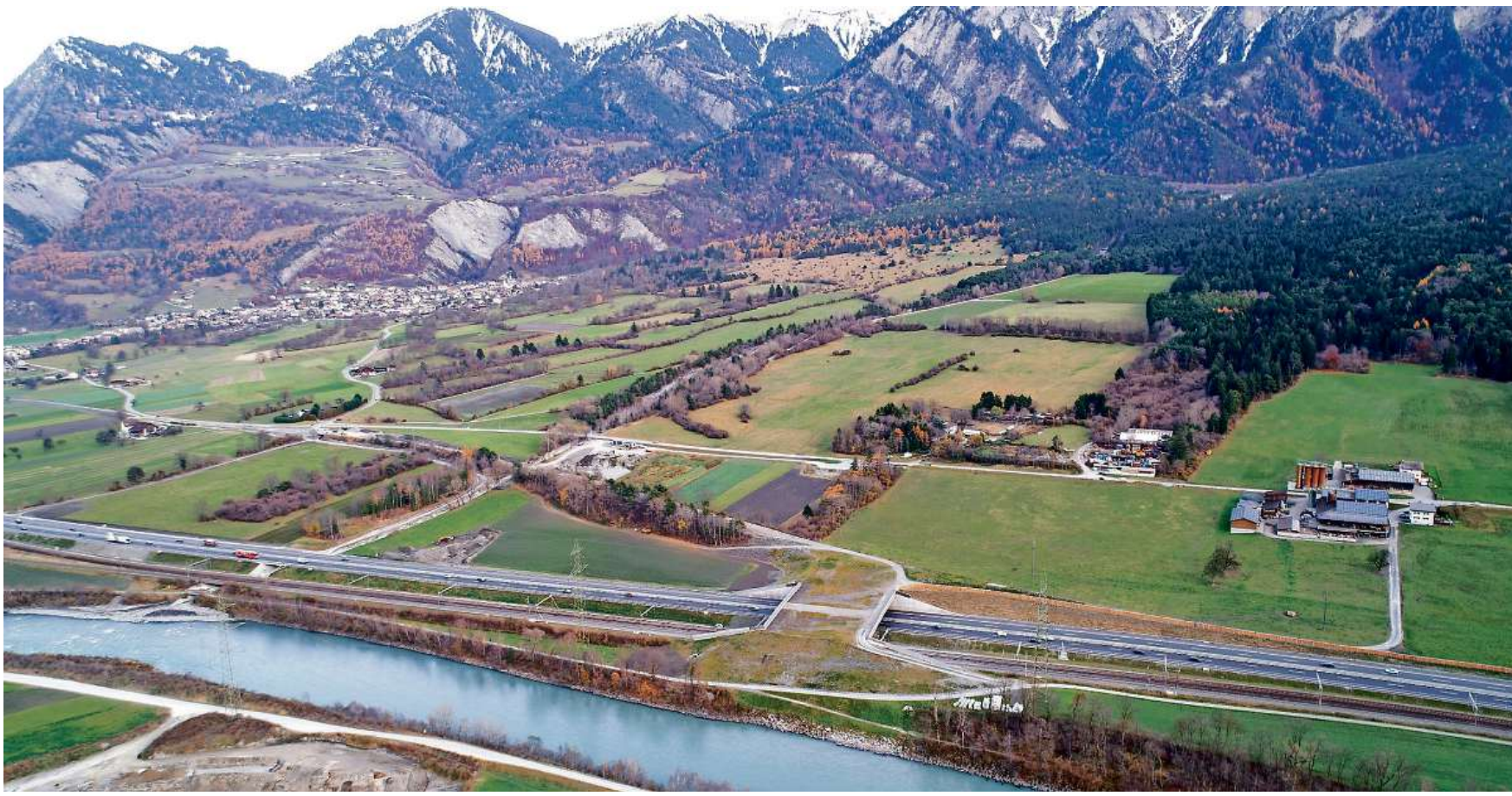
Die neue Wildbrücke über die Autobahn (Mitte) hat auch Auswirkungen auf die Streckenführung des geplanten Radwegs Trimmis-Chur.
